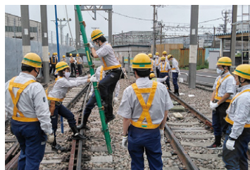
架線作業に関する実習
