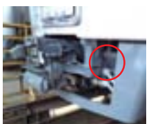
転落防止放送装置
