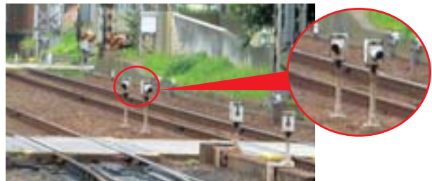
踏切障害物検知装置
