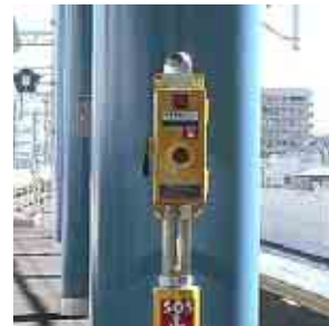
非常通報ボタン
