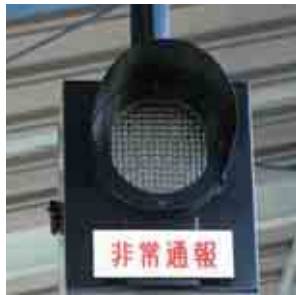
非常通報表示灯
