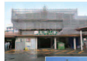
工事中の高野山駅
