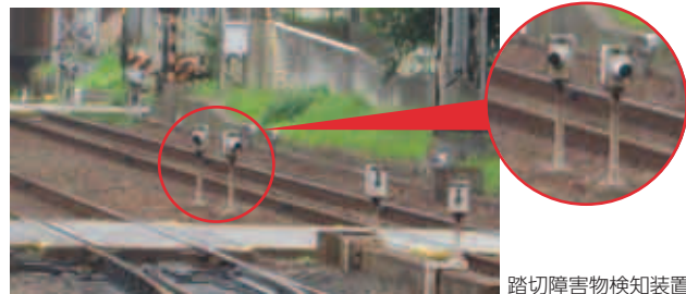
踏切障害物検知装置
