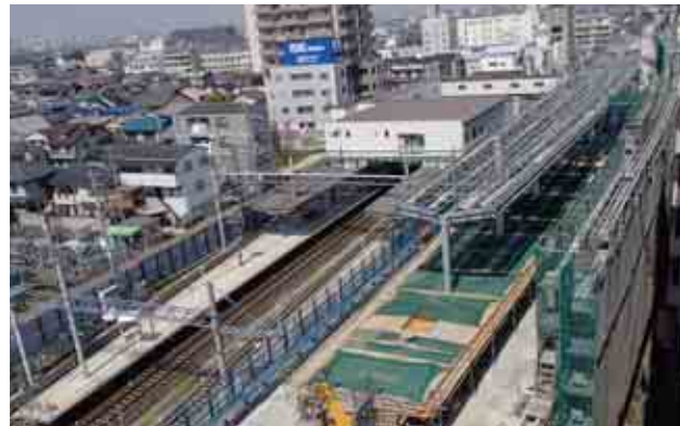
南海本線高石駅の工事の様子
