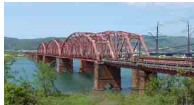
南海本線・紀ノ川橋梁
