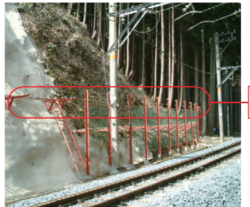
落石警報装置の検知線
