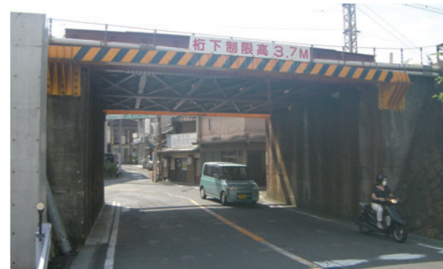
桁下有効高表示と防護柵
