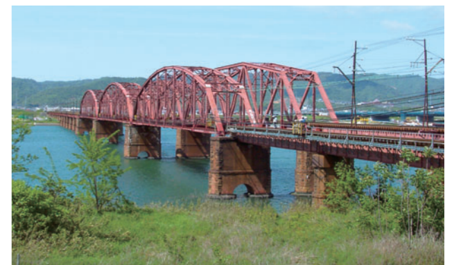
南海本線・紀ノ川橋梁(紀ノ川～和歌山市間)
