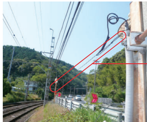
自動車転落警報装置の検知線
