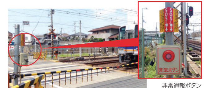
非常通報ボタン
