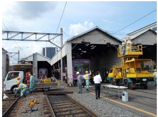
(写真：嵐山線総合復旧訓練)
