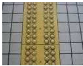
神戸市型 点字ブロック JIS化改修
