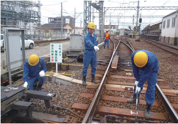
点検作業の様子
