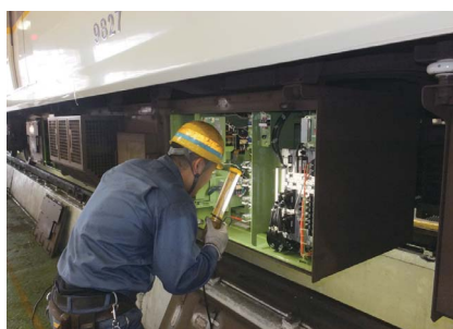
制御装置の検査
