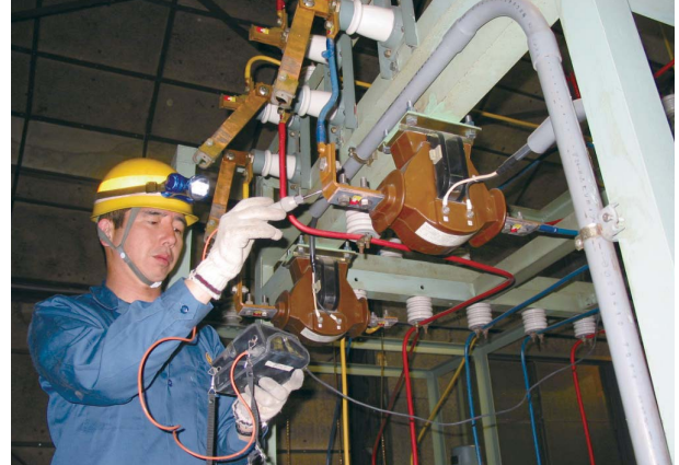
変電所設備保守点検
