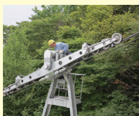
支索(ロープ)の検査
