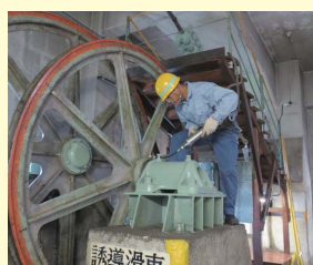
誘導滑車の検査
