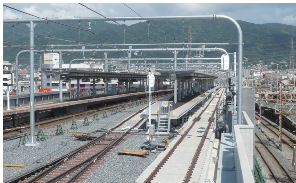
奈良線八戸ノ里・瓢箪山間連続立体交差化工事（東花園駅）
