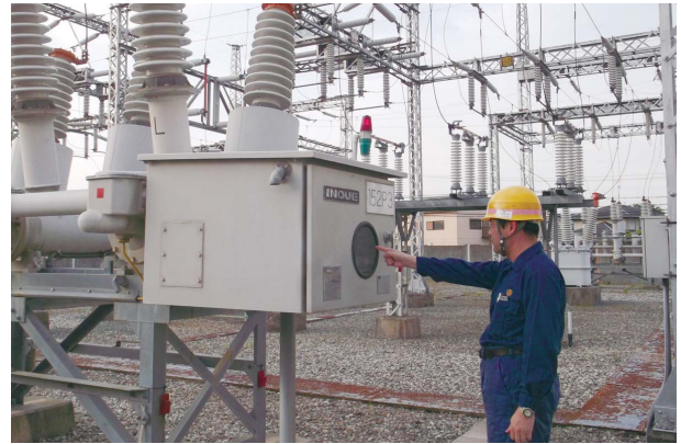
変電所設備保守点検
