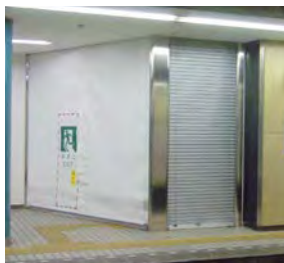
シャッターと耐火スクリーンを下ろした状態
