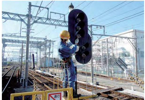
信号保安装置検査
