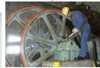
誘導滑車の検査
