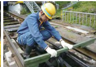
ロープ・誘導滑車の検査
