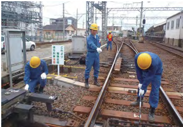
点検作業の様子
