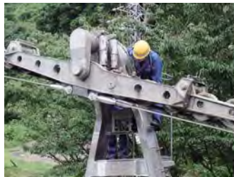
支索(ロープ)の検査
