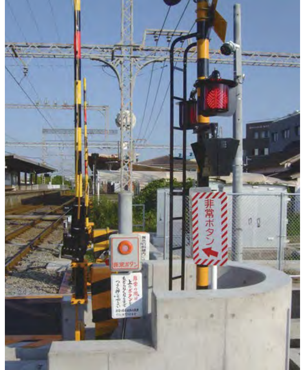
押ボタン式踏切支障報知装置
