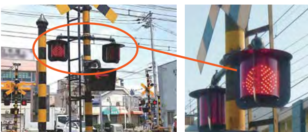
全方向踏切警報灯
