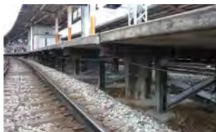
ホーム下の待避スペース
