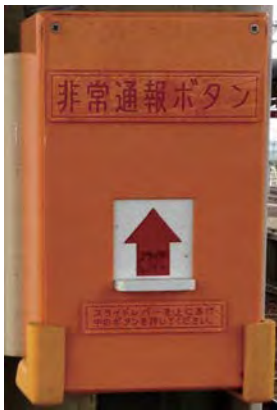
非常通報ボタン
