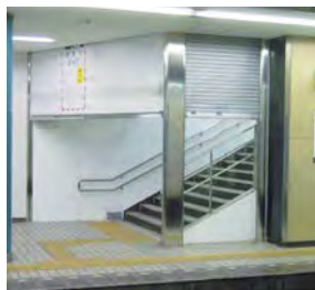
階段防火区画のシャッターと耐火スクリーン（白色）を下ろしている途中
