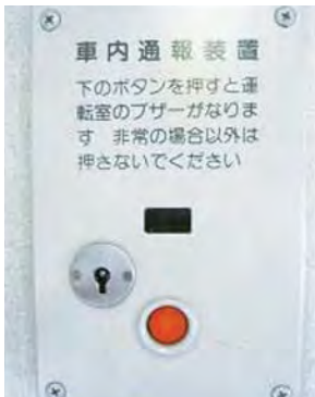
車内通報装置
