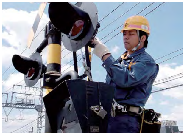
踏切保安装置検査
