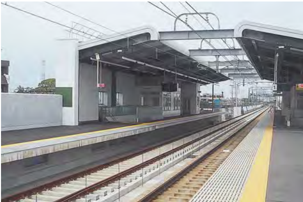
名古屋線近鉄伏屋駅付近立体高架工事
