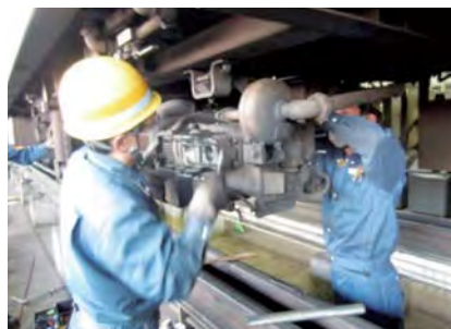
⑨ 電動空気圧縮機の検査
