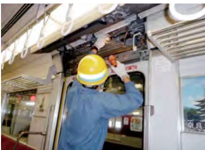
⑧ 戸閉装置の検査
