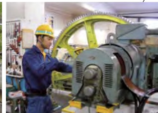
ロープ巻上げ電動機の検査
