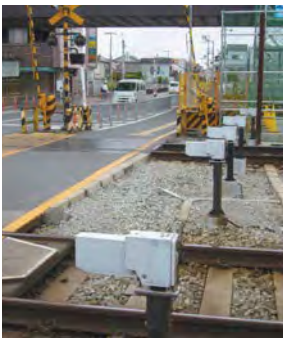
踏切障害物検知装置
