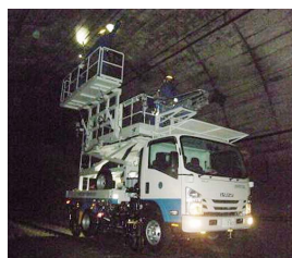
トンネル検査
