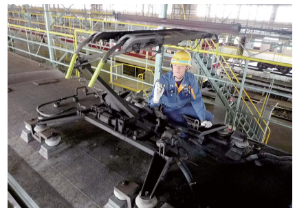
④パンタグラフの検査
