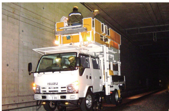
作業自動車による電車線検査（夜間作業）
