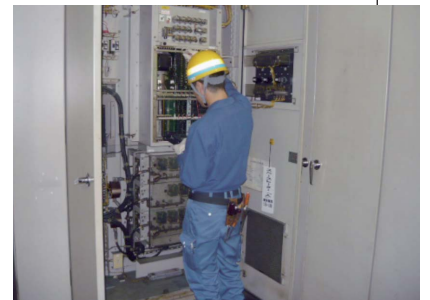
④けん引用ケーブル・巻上げ装置制御器の検査
