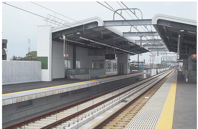
名古屋線伏屋駅付近立体交差化工事
