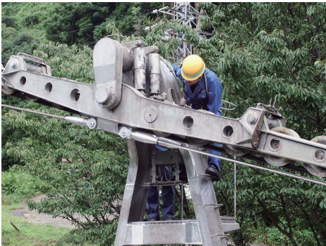
①支索(ロープ)の検査
