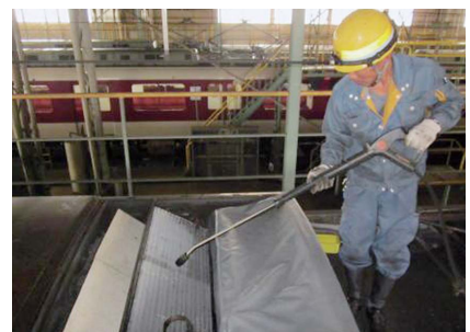
⑥クーラー室外機の清掃
