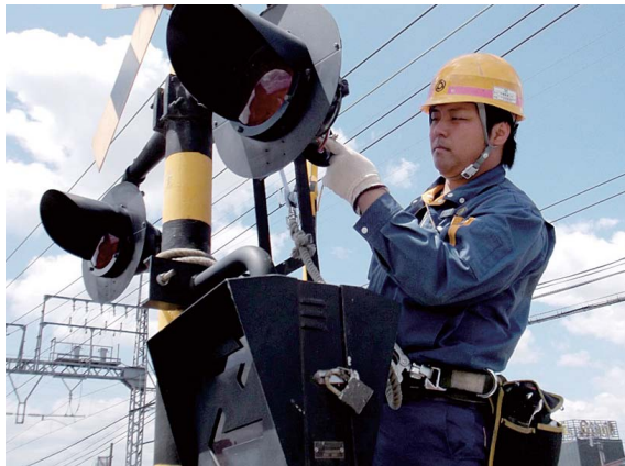
① 踏切保安装置検査
