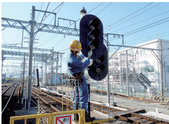
③ 信号保安装置検査
