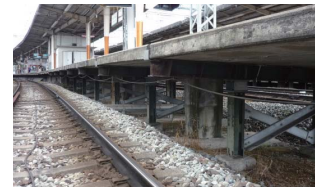
ホーム下の待避スペース
