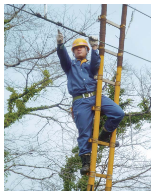
④ 架線点検
