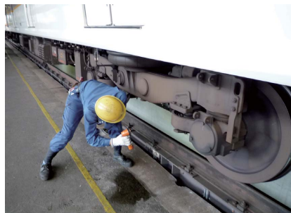
③台車・ブレーキ装置の検査
