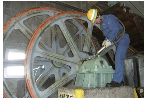
③誘導滑車の検査
