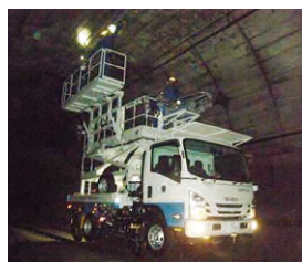
トンネル検査
