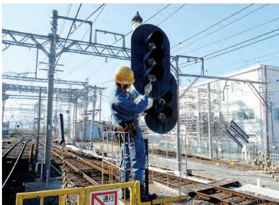
③ 信号保安装置検査
