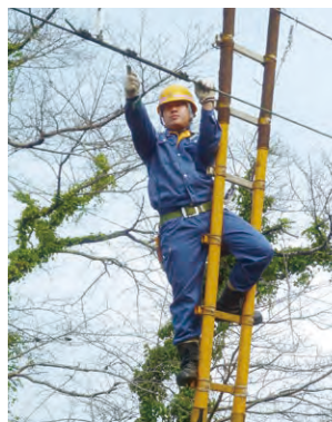
④ 架線点検
