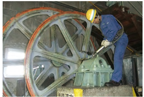
③誘導滑車の検査
