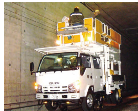
軌陸車による電車線検査(夜間作業)
