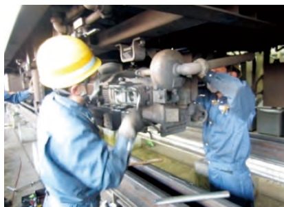
⑩電動空気圧縮機の検査
