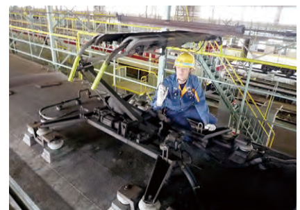
④パンタグラフの検査
