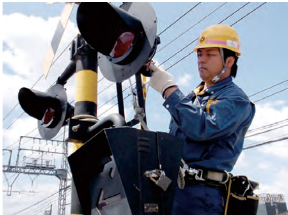
① 踏切保安装置検査
