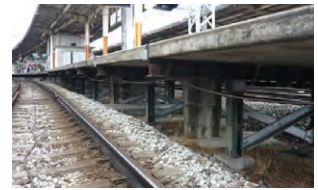
ホーム下の待避スペース
