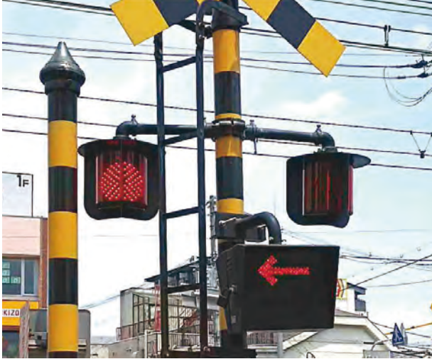
④ 全方向踏切警報灯
