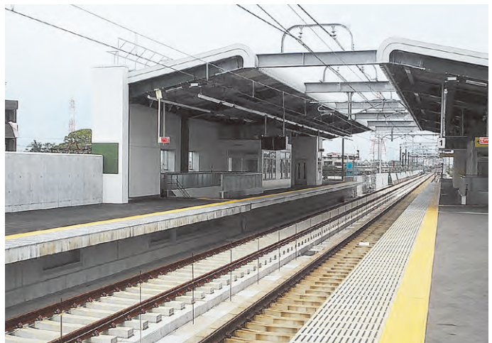
名古屋線伏屋駅付近立体交差化工事
