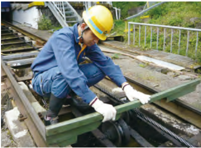
①けん引用ケーブル・誘導滑車の検査
