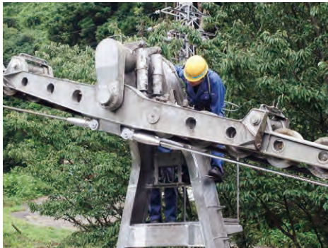
①支索(ロープ)の検査
