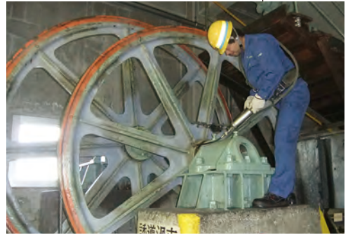
③誘導滑車の検査
