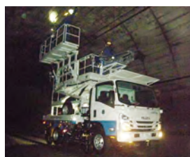
トンネル検査
