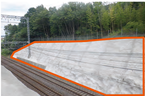
法面補強(三本松～赤目口間)
