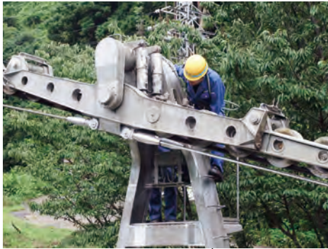
①支索(ロープ)の検査
