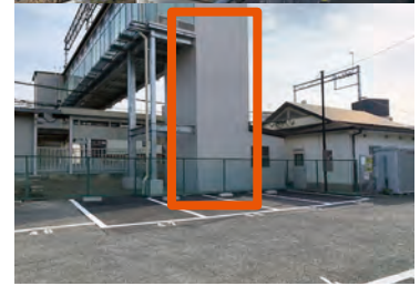
布忍駅跨線橋付きエレベーター全景
