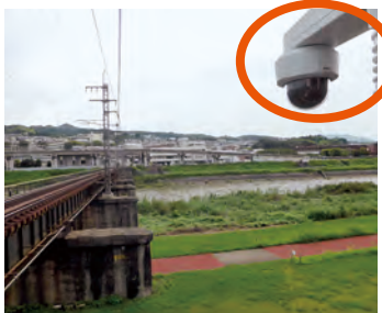
河川監視カメラ (大和川橋梁王寺～信貴山下間)
