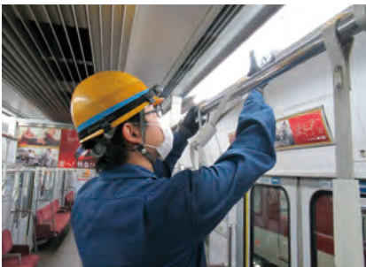
車内灯の検査
