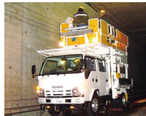
軌陸車による電車線検査(夜間作業)
