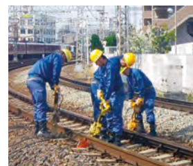
⑥ 線路の補修作業（つき固め作業）
