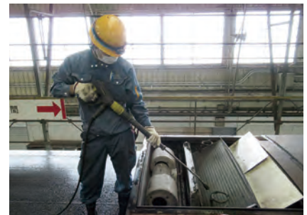
⑤クーラー室外機の清掃
