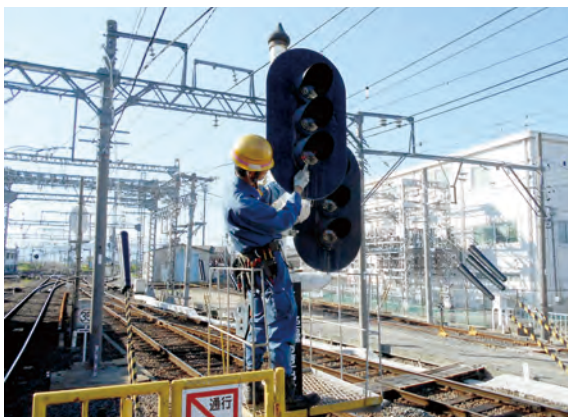
③ 信号保安装置検査
