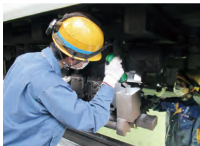
⑦電動空気圧縮機の検査
