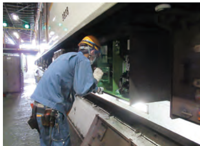
④制御装置の検査
