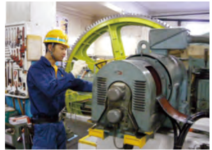
③けん引用ケーブル・巻上げ電動機の検査
