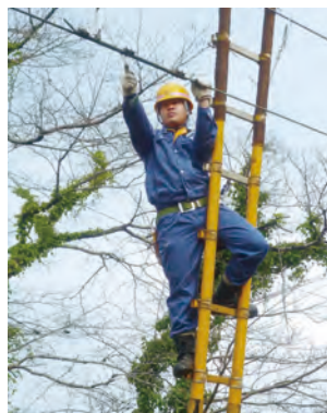
④ 架線点検
