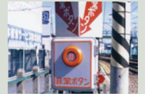
【非常ボタン(踏切支障報知装置)】
