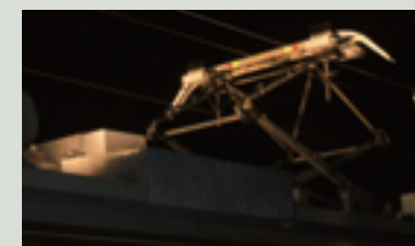
【レーザー光線によるトロリ線摩耗測定】
