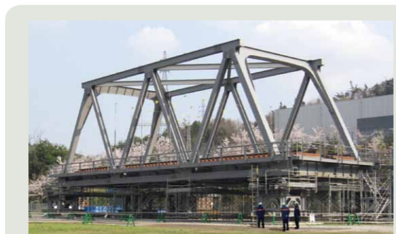
【試験トラス橋】
