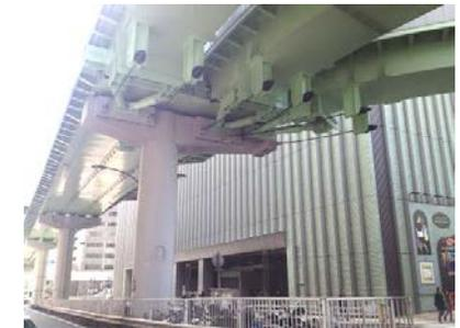
耐震補強(落橋防止)後の桁
