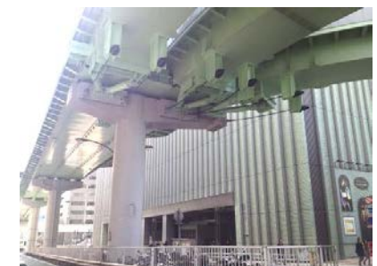
耐震補強(落橋防止)後の桁
