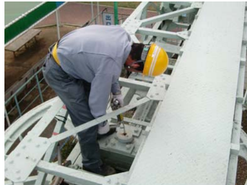
特殊索道(観光リフト)緊張滑車の点検
