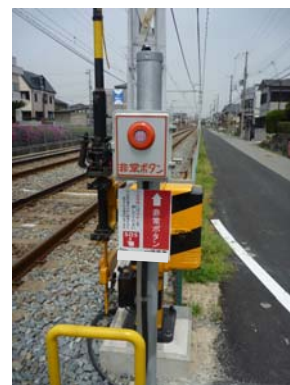
非常通報押しボタン
