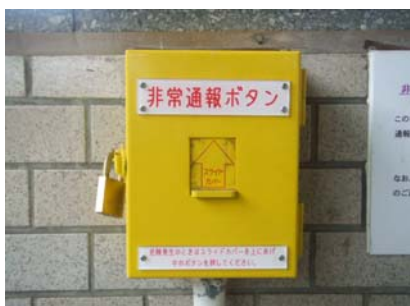
非常通報押しボタン
