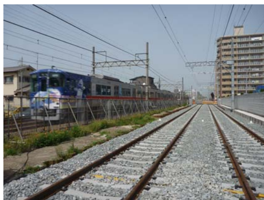
在来線と仮線路
