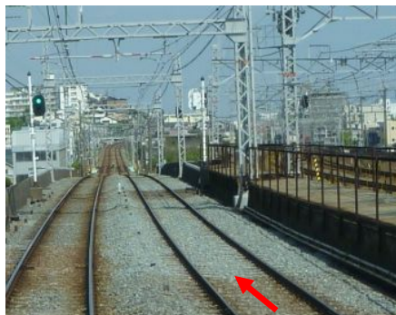
垂水駅東方の道床交換
