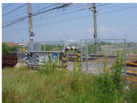
加古川橋梁東岸南側立入防止柵
