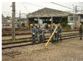
線路復旧作業
