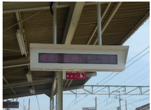
江井ヶ島駅上り列車接近案内装置
