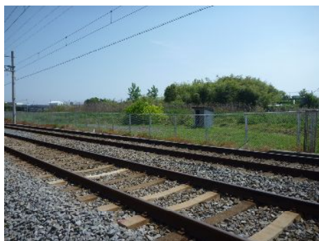
山陽魚住駅～東二見駅間
