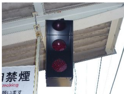
非常通報表示灯
