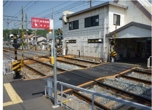
曽根駅渡線道に設置した押しボタン
