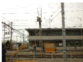
架線復旧作業
