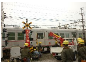
踏切装置復旧作業
