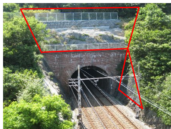
的形トンネル東側坑口落石防護
