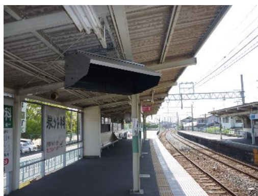
改善後の乗降監視用モニター
