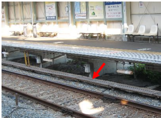
滝の茶屋駅のホーム下に設置している検知マット
