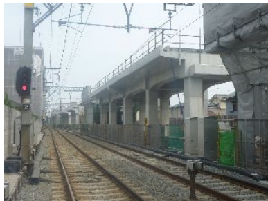
建設が進む高架橋
