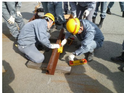
レール折損時の応急処置訓練
