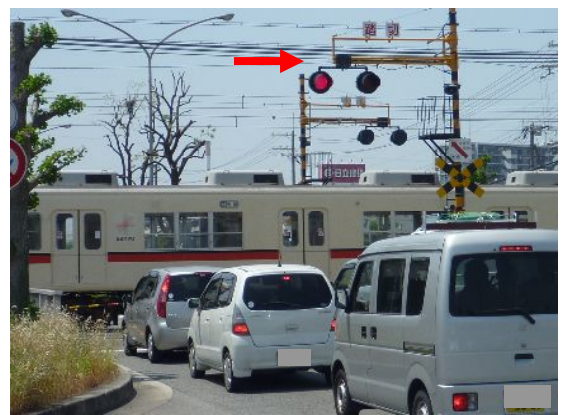
新下野田踏切道のオーバーハング型警報装置
