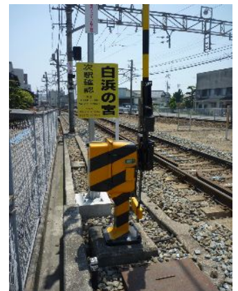
更新した飾磨東踏切道自動遮断機
