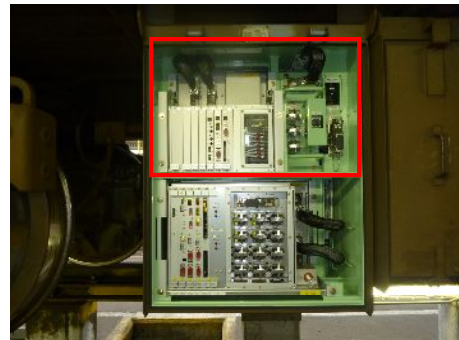
運転状況記録装置
