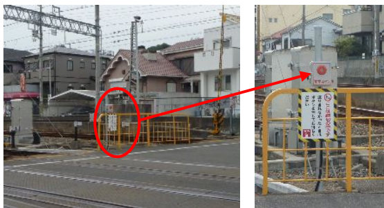
東須磨踏切道
