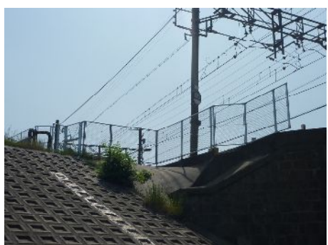
加古川橋梁東岸北側立入防止柵
