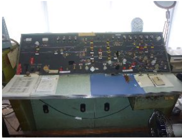
更新前の東二見駅連動制御盤
