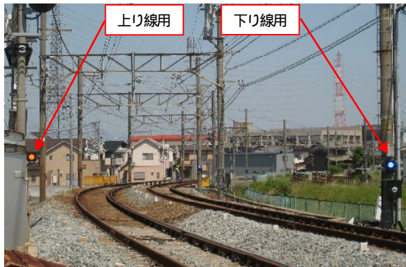
加古川東曲線～加古川橋梁の区間の列車接近警報装置
