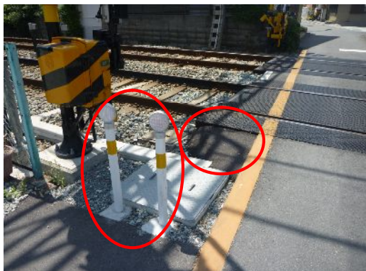
段差部の舗装と進入防止用ポール
