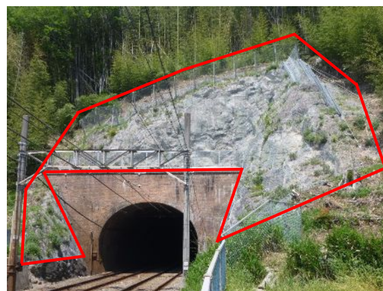
妻鹿トンネル東側坑口落石防護
