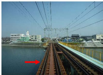
下り線の鉄橋用まくらぎを更新した洗川橋梁
