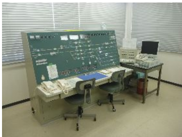
更新後の東二見駅連動制御盤
