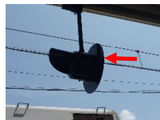
背板を取付けた出発反応標識
