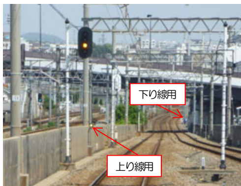
大蔵谷駅～人丸前駅間の列車接近警報装置
