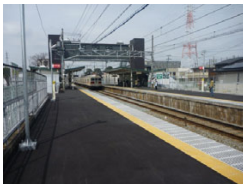
浜の宮駅におけるホーム段差解消
