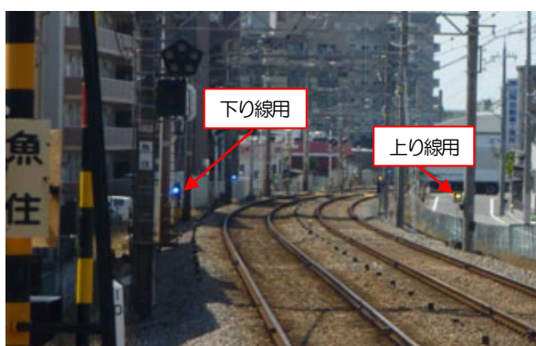
魚住駅～東二見駅間の列車接近警報装置
