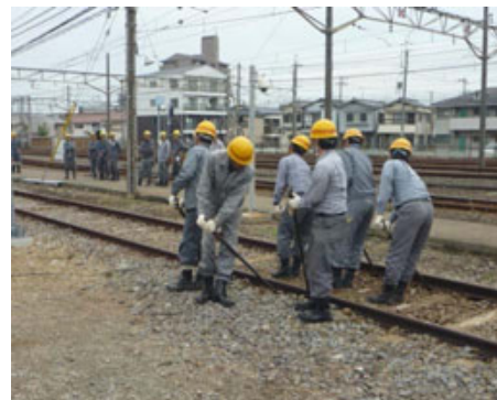
線路復旧作業
