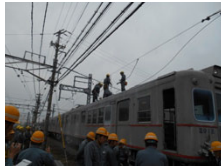
架線復旧作業
