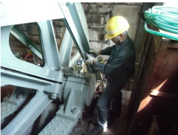
普通索道（ロープウェイ）緊長滑車の点検状況
