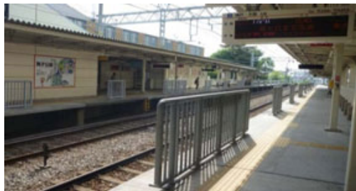
舞子公園駅固定式ホーム柵
