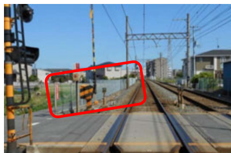
西二見駅～播磨町駅立入防止柵
