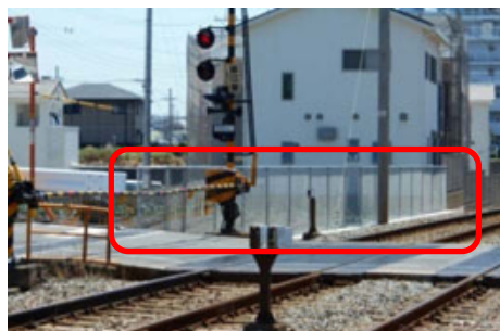
林崎松江海岸駅～藤江駅間立入防止柵
