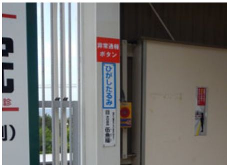
非常通報ボタンの位置がわかりにくい
