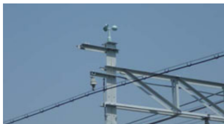
市川橋梁風速計
