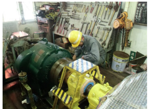
特殊索道（観光リフト）原動機の点検状況
