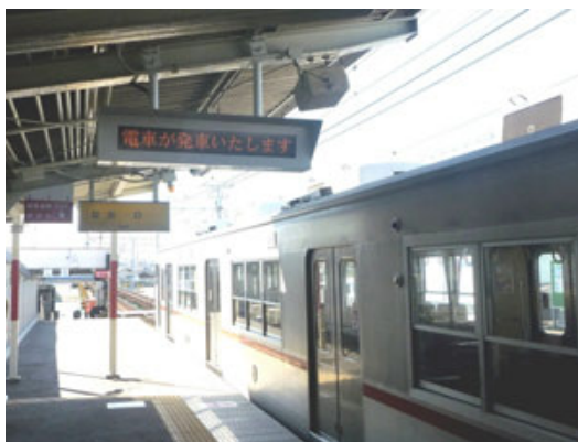
妻鹿駅下りホームの列車接近案内装置
