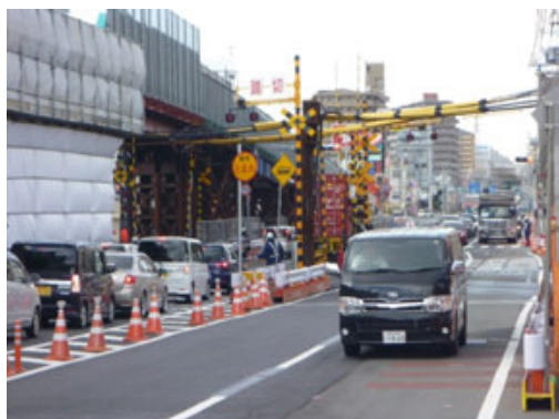
工事の進捗により、一時平面交差化した国道2号
