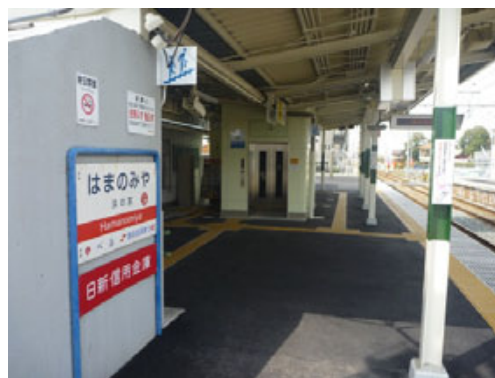
浜の宮駅に設置したエレベーター
