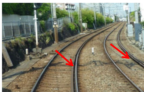
須磨寺駅東方の脱線防止ガード
