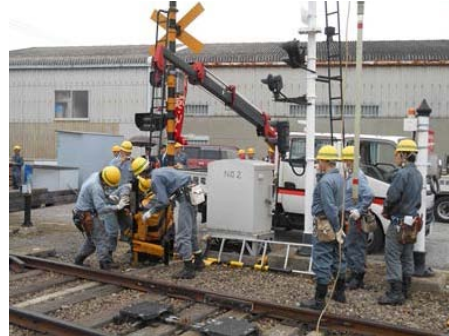
踏切装置復旧作業
