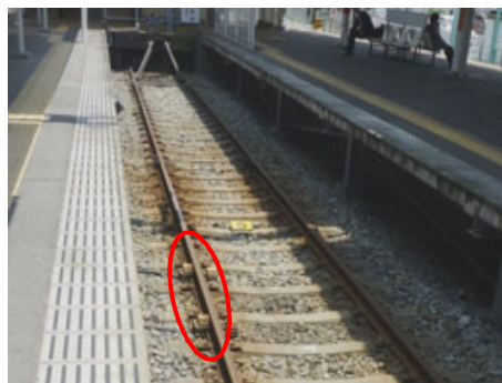
飾磨駅線路終端部の速度超過防止用ATS
