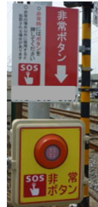
踏切非常通報ボタン
