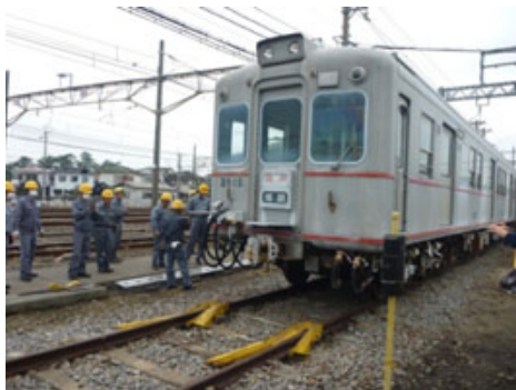
車両復線作業
