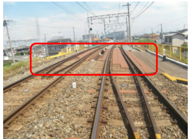
まくらぎを更新した尾上の松架道橋
