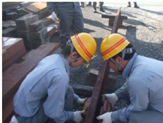
レール折損時の応急処置訓練
