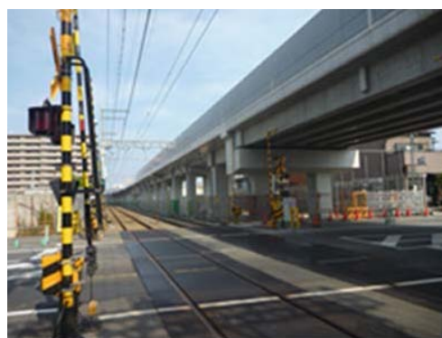
高架切替後に廃止となる林崎学校道踏切道 (2015年6月20日高架線への切替工事が完了しました。)
