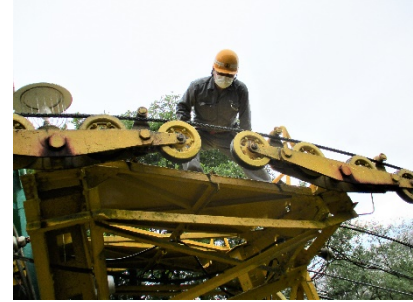
観光リフトの受索輪の点検状況
