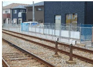
中八木駅—江井ヶ島駅間の立入防止柵
