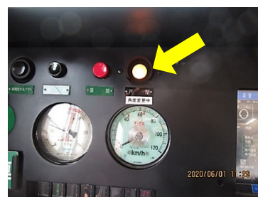
運転台の戸閉表示灯
