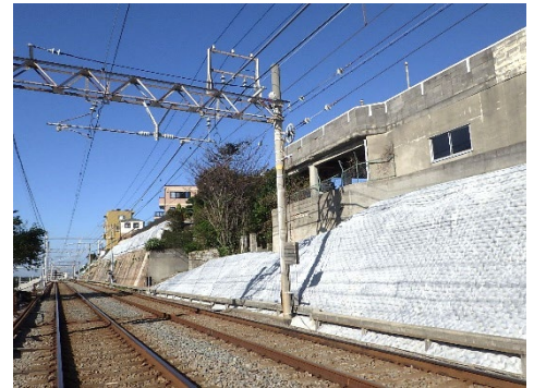
滝の茶屋駅西方法面防護工
