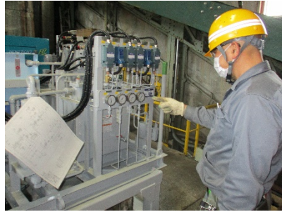
ロープウェイの制動装置油圧ユニット点検状況
