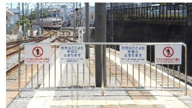
設置したホーム端部安全柵
