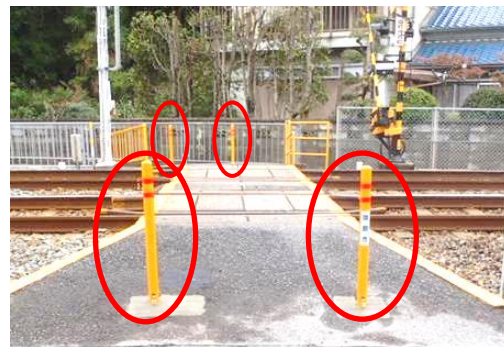
規制杭を設置した的形地蔵前踏切
