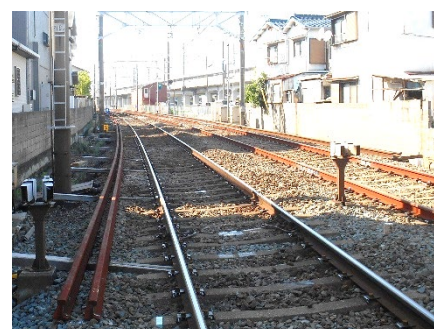
播磨町駅-別府駅間のレール更新箇所
