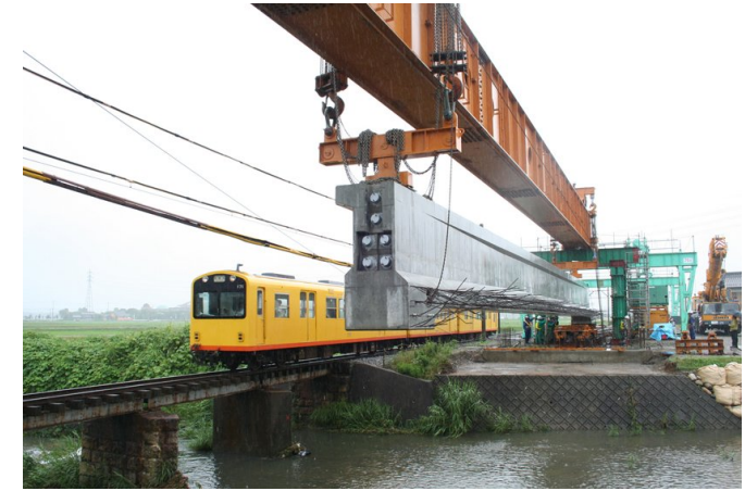
藤川橋梁架替工事(2008.12.7)
