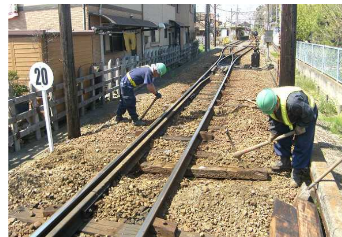
北勢線並マクラギ更換工事
