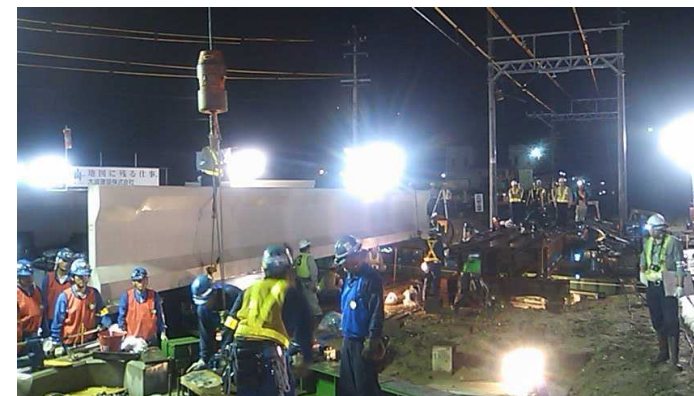
萱生川河川改修工事
