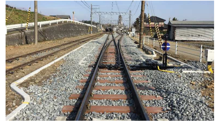
三岐線 東藤原駅構内重軌条化工事
