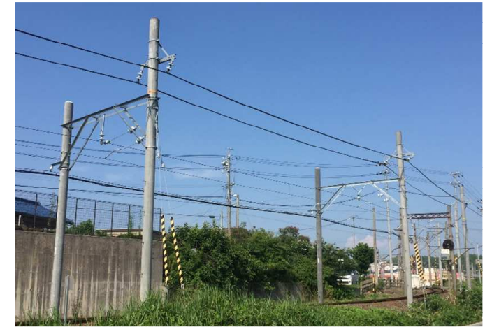
北勢線 電柱更新工事
