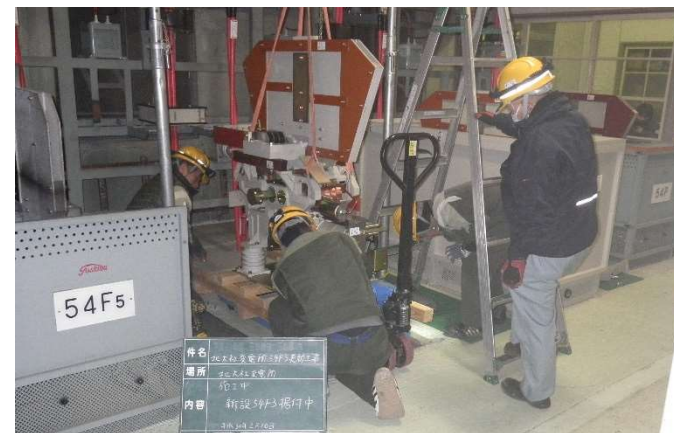
北勢線 変電所設備更新工事
