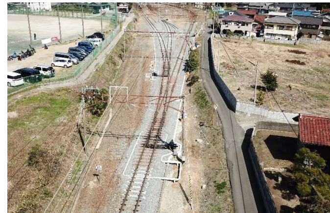
三岐線 伊勢治田駅構内重軌条化工事
